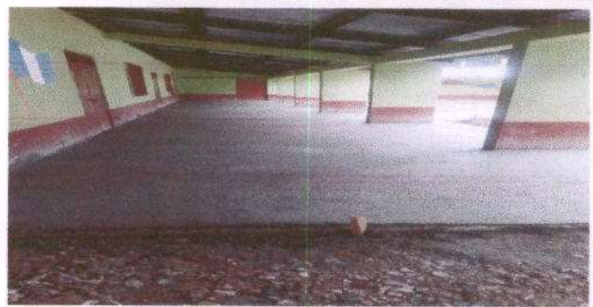
Foto 6: El piso deteriorado es sustituido por piso de concreto en el corredor.
