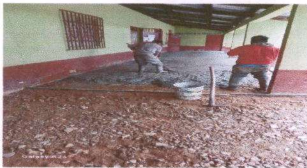
Foto 6. Proceso de fundición de piso concreto en el corredor de la escuela..
