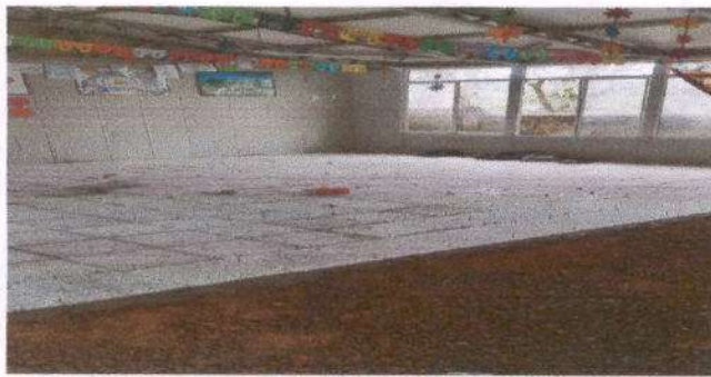
foto 3: Colocación de piso granito en una de las aulas prefabricadas.
