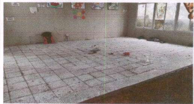
Foto 4. Proceso de colocación de piso granito en otra aula que era de tabla roca.
