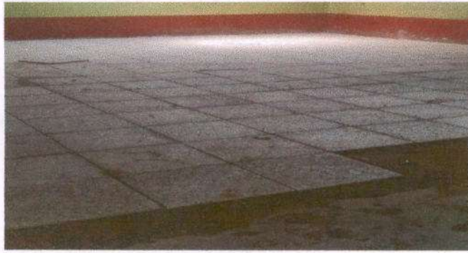
Foto 1: Proceso de colocación del piso granito en una de las aulas..
