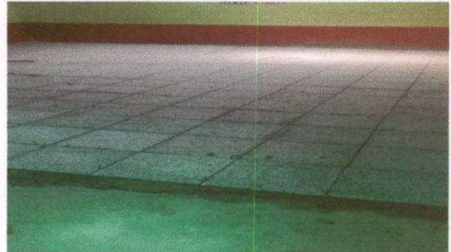
Foto 2: Colocando piso granito en otra aula.
